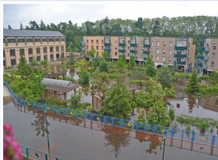
Le quartier Matra a été conçu pour résister à la crue de la Sauldre : bâtiments sur pilotis, sols poreux, route surélevée...
